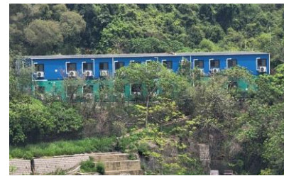
興建地盤辦公室 Construction of site office
